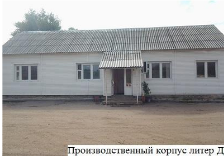
Производственный корпус литер Д
